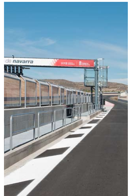
Instalación de los canales Monoblock RD200 de ACO en la pista del Circuito Los Arcos
