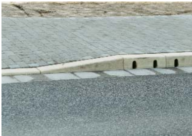
ACO KerbDrain® con elementos en pendiente para acceso a garaje.
