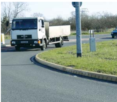
ACO KerbDrain® para el drenaje de rotondas.
