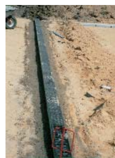
Colocar los canales sobre el hormigón
