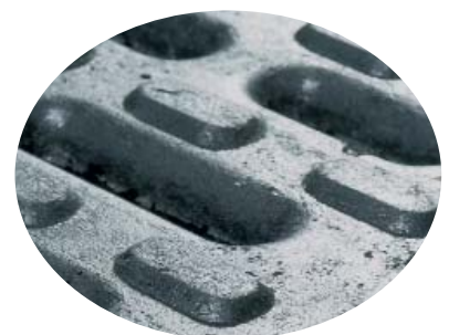
Detalle de las aperturas para drenaje en hormigón polímero
