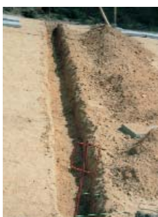
Preparación del terreno
