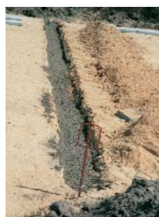
Verter el hormigón
