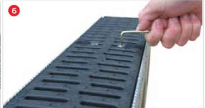
6 Apriete de los tornillos con una llave Allen. La reja queda fijada.
