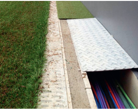
Self 300 con reja ciega para cableado
