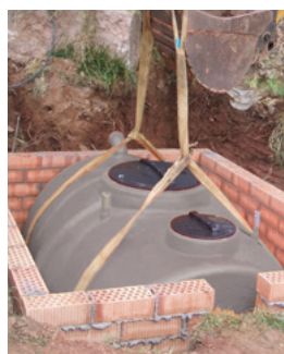
NECOR 5 vivienda moradia unifamiliar
