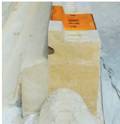
Canal y cimientos colocados al lado la carretera, con un soporte en un lado. Canal e alicerces colocados ao lado da estrada, como um suporte num lado.
