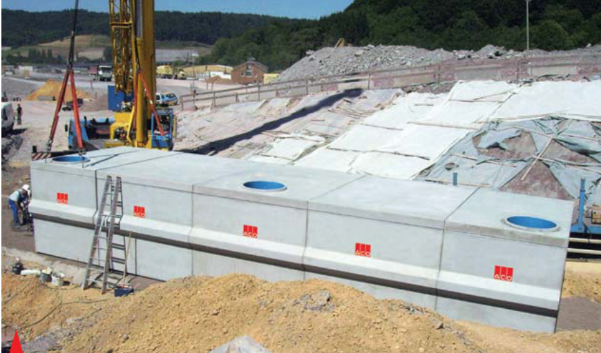
Exemplo de instalação de um tanque de água de extinção com 100.000 litros na Universidade de Mainz, Alemanha.
