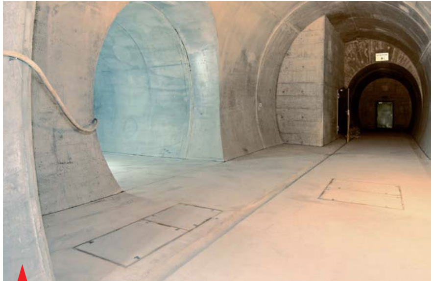
As tampas de visita da ACO utilizadas como acessos para inspeção no túnel de Wattkopf
