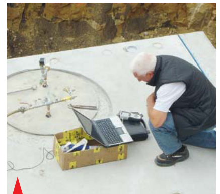
Utilização de ar comprimido para verificar a estanquidade.
