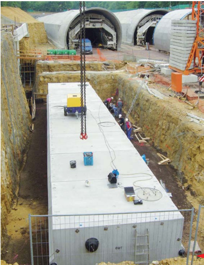
Exemplo de instalação de um tanque de água de extinção com 100.000 litros na Universidade de Mainz, Alemanha.
