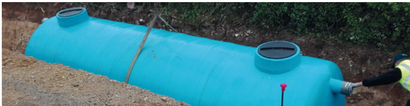
Instalación depósito DRP
