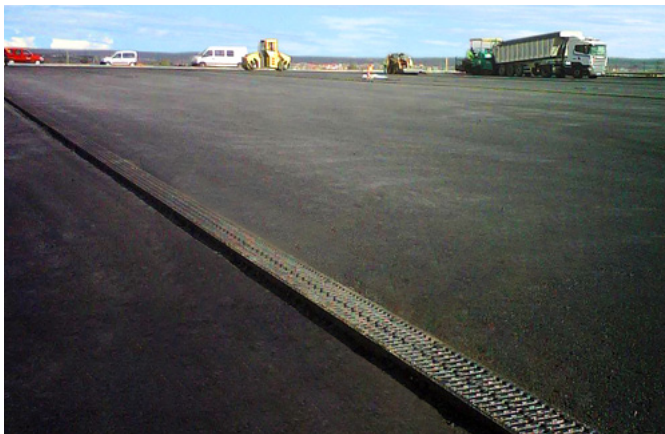
Detalle del canal S300 instalado en el lateral de pista.
